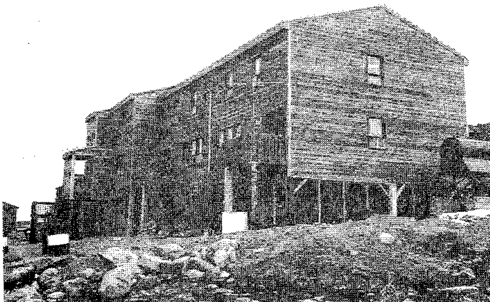
Eksempel på canadisk punktfundering på træ søjler.
