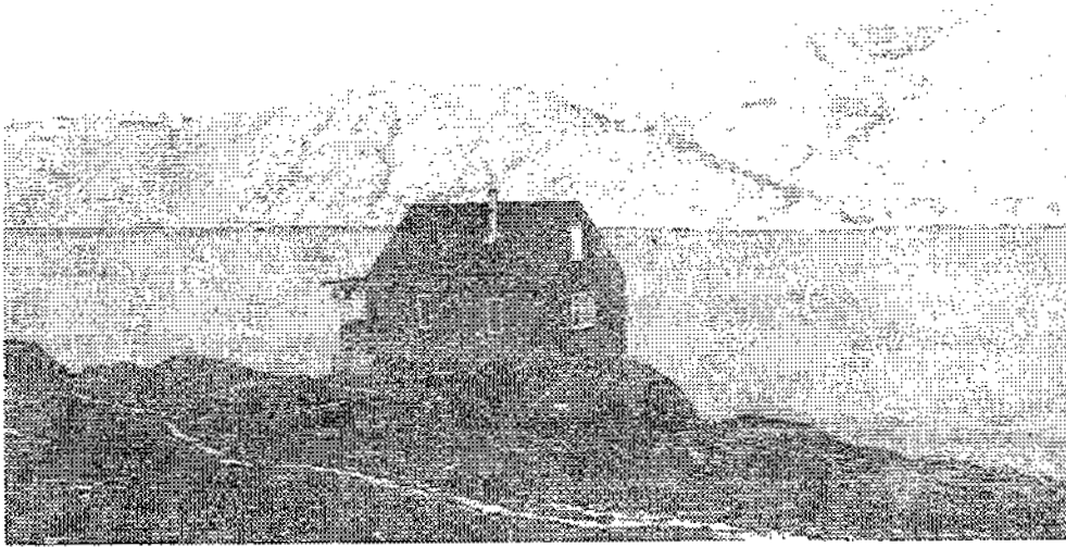
Eksempel på ældre stolpefunderet bygdehus.
